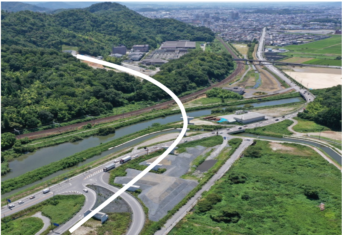
国道 8 号バイパス (米原バイパス 9 工区) [彦根市松原地区 ~ 米原市入江地区]
